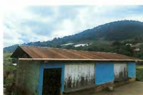
Foto 2: Sustitución de canal de tubo, por canal tipo Americano e instalación de pescante de metal y sustitución de bajada de agua pruvial por tubo PVC
