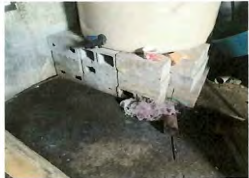
Foto 8: Base de block y cemento para tinaco
