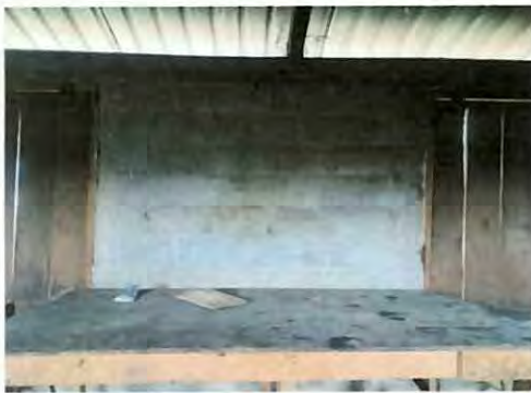
Foto 9: Elaboración de mesa de concreto y azulejo con puertas de metal
